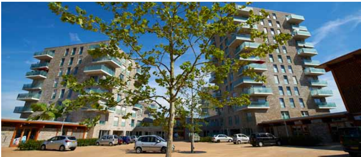
100 zorgwoningen aan de Distelvlinderlaan
