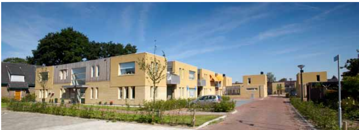
11 zorgwoningen aan het Sebastiaanplein 4a t/m 10c
